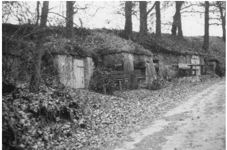
Abb. 2: Felsenkeller im Hohlweg der »Schindhölzleinsgasse«.
