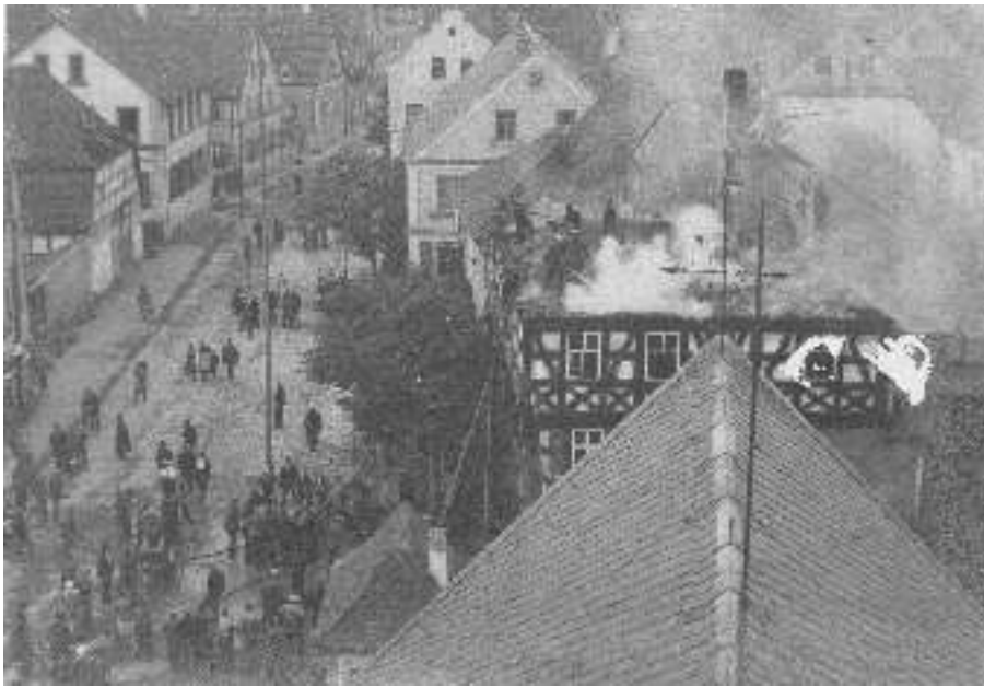
Abb. 6: Brand des Oberen Wirtshaus es im Oktober 1929.
