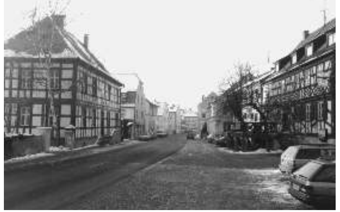
Abb. 8: Aufgeweiteter Straßenraum der Bamberger Straße von der Kirche Richtung Westen. Links das ehem. crailsheimische Amtshaus, rechts das Wirtshaus von 1707. Foto: Th. Nitz
