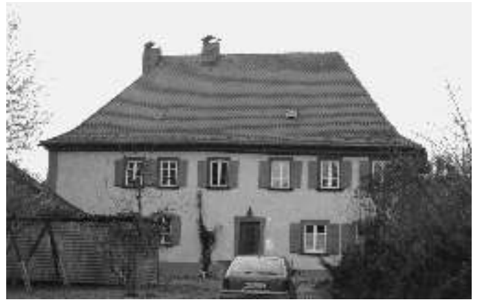
Abb. 10: Schulstraße 1, Pfarrhaus. Zweigeschossiger Massivbau mit Walmdach, Ende 18. Jahrhundert (Denkmal). Foto: Th. Nitz
