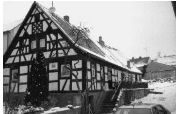
Abb. 12: Bamberger Str. 11, ehem. Marrhof/Geislerischer Hof. Erdgeschossiges Wohnstallhaus mit Satteldach, Fachwerk, bez. 1747 (Denkmal). Foto: Th. Nitz
