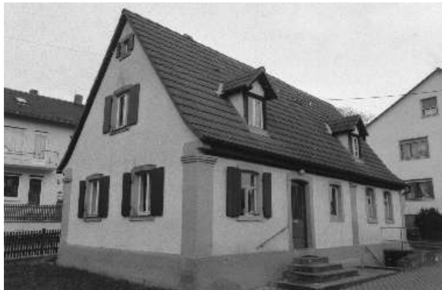
Abb. 15: Schulstraße 2, eingeschossiges Wohnhaus mit Satteldach, massiv verputzt, um 1870, Beispiel für ein Tropfhaus.
